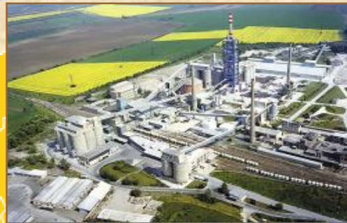
Lafarge Cement, a.s. - Čížkovice
